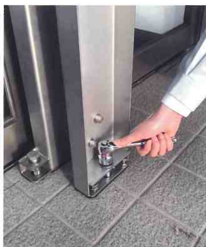
中間支柱を組み立てる (横分割有りの場合)
